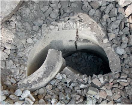
**Abb. 3:** Bei derartigen Beschädigungen kann keine Spülung durchgeführt werden. Tiefbautechnische Erneuerung ist erforderlich.
