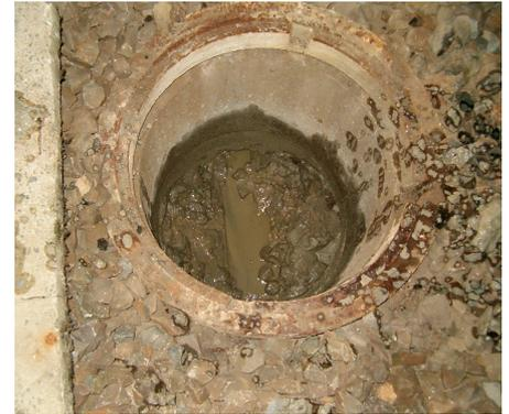
**Abb. 5:** Schlamm und Schotter behindern den Wasserverlauf.
